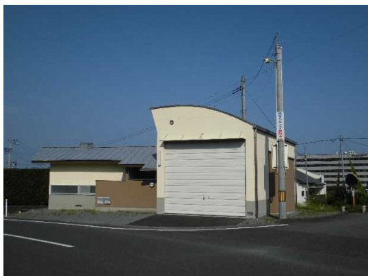
ポンプ分団屯所
