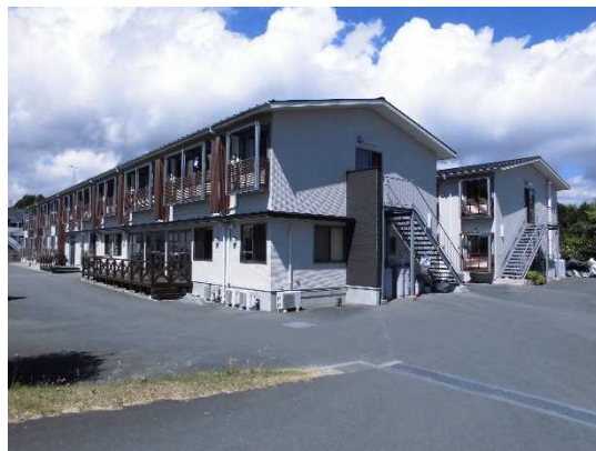
広野町仮設宿泊施設（ホテルリーブス）
